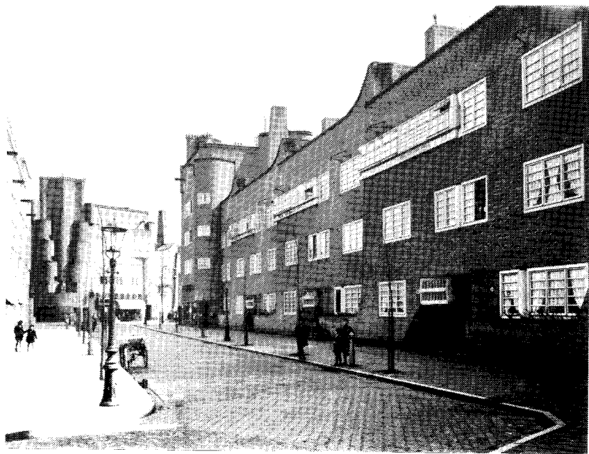
Figuur 4. Arbeiderswoningen in de Pijp. Arbeiderswoningen van de Amsterdamse School gelegen in de Pijp te Amsterdam (Bron: Historisch topografische atlas G.A.A. neg.nr. D38997)
